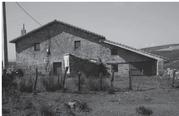
Cabaña central de El Escudo, una edificación reformada.
