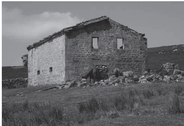
Cabaña en ruina en el cabañal de El Escudo. Son apreciables su volumetría y reparto de vanos.
