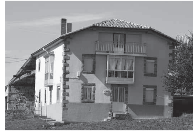
Casa de La Población de Yuso, buen ejemplo de la arquitectura del contacto pasiego-campurriano.
